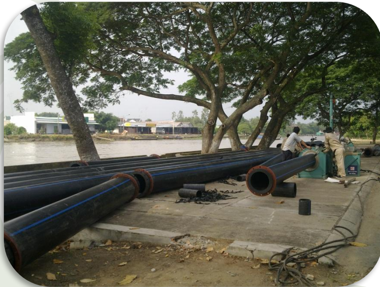
Công trình nạo vét sông tại Đồng Tháp MỸ ĐÈ
