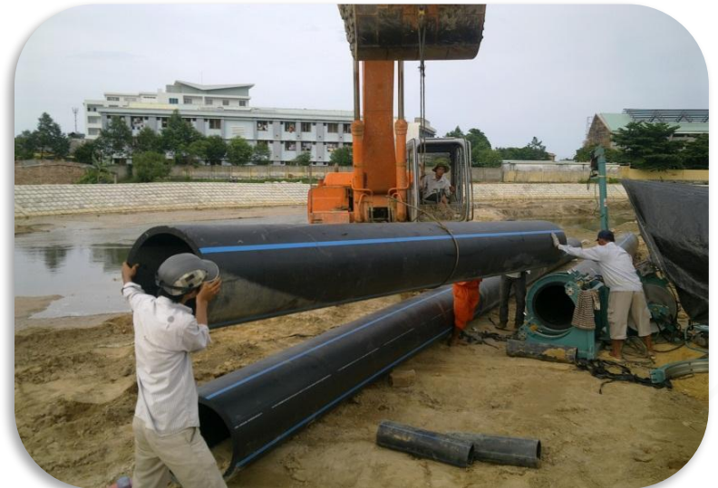
Công trình Kênh Phú Lộc, Đà Nẵng
