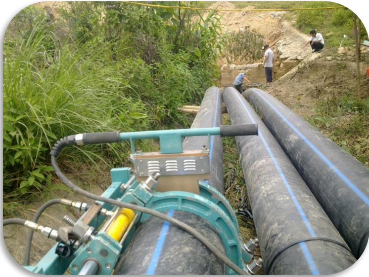
Công trình thủy lợi xã Hòa Phú, Đà Nẵng
