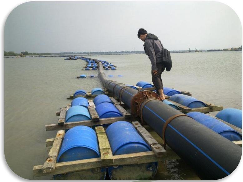
Công trình nạo vét tại Phú Quốc, Kiên Giang
