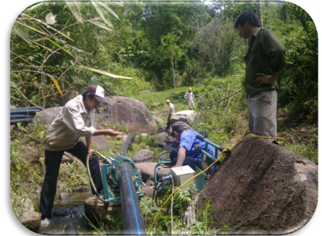
Công trình thủy lợi tại LÀO
