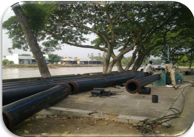
Công trình nạo vét sông tại Đồng Tháp Mười
