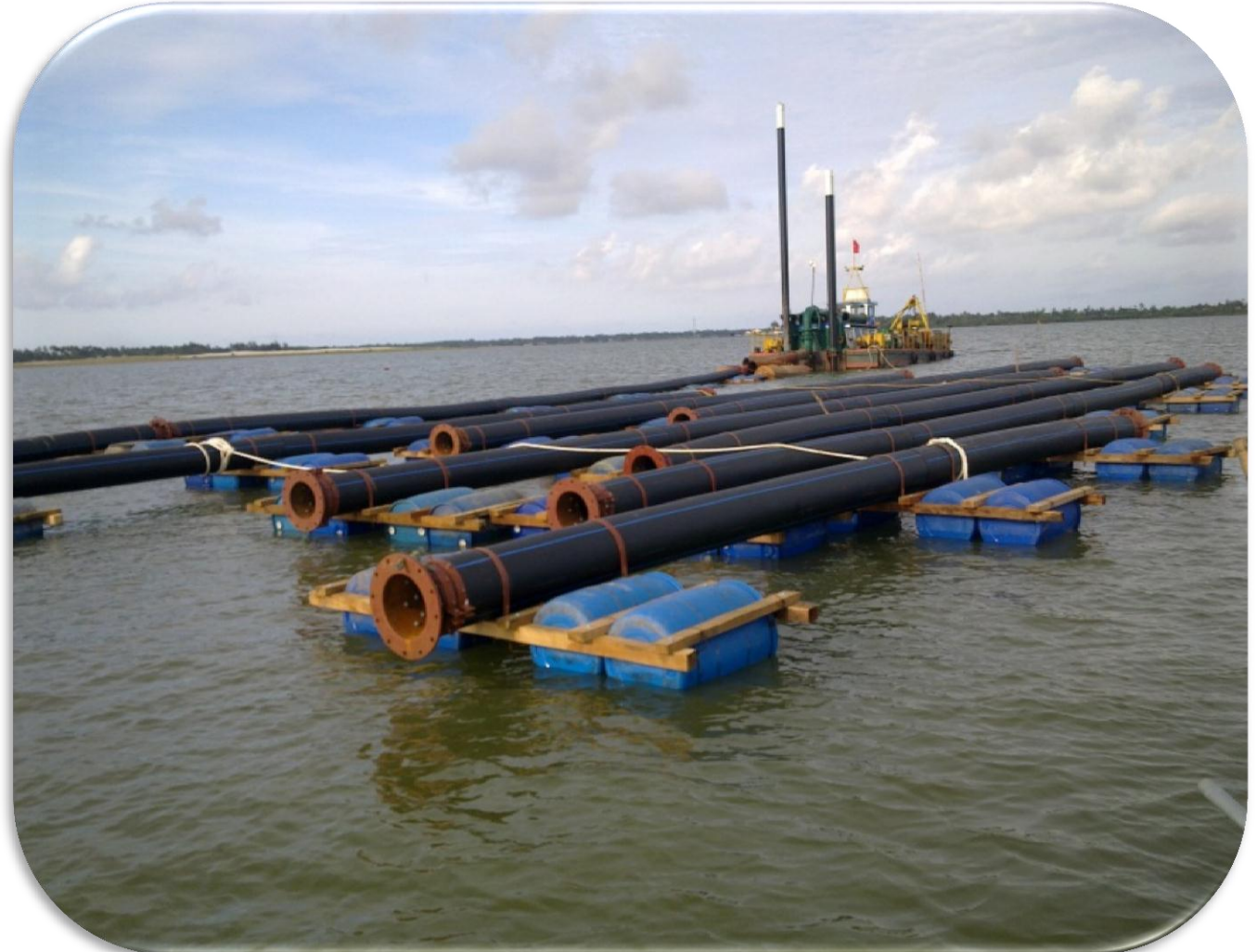
Công trình sông Trường Giang, Quảng Nam
